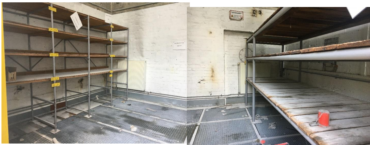
Abb. 4-1 Blick in das ehemalige Lösemittel- und Farblager
