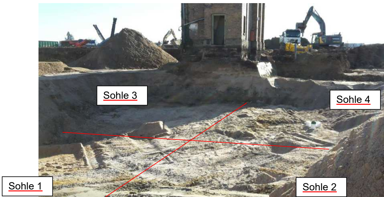
Abb. 4-1 Blick über die Baugrube auf südwestlicher Teilfläche, zwischen ehem. „Alte Rohbauhalle“ und dem Gebäude „Farb- und Lösemittelager“ mit Beprobungsfeldern (23.11.2022).
