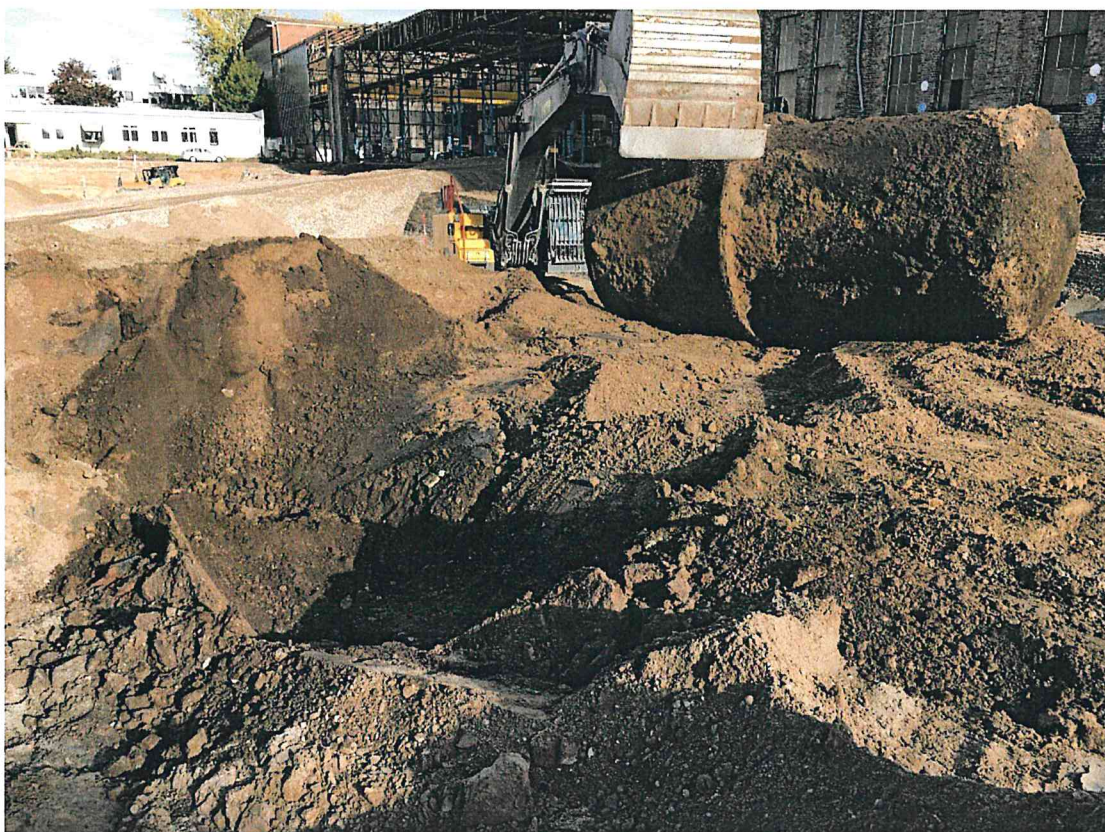
Dunkle Auffüllungen seitlich des Tanks, mit geringen Anteilen an Bauschutt , Schlacke und Straßenaufbruch.
