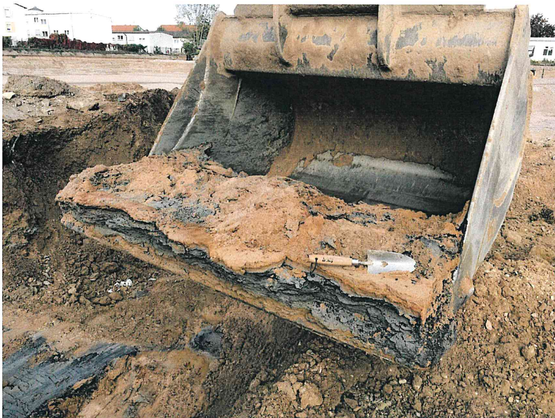
Dunkle Auffüllungen seitlich des Tanks, mit geringen Anteilen an Bauschutt , Schlacke und Straßenaufbruch.
