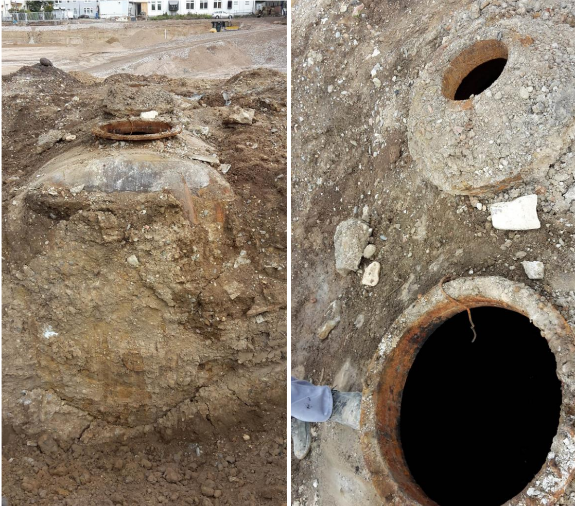
Abb. 4-1 Blick auf den Erdtank. Im rechten Bild sind die beiden Tanköffnungen zu sehen. Diese und die Position des Erdtanks lassen vermuten, dass es sich um den nachgeschalteten Tank nach dem Ölabscheider aus der hydraulischen Sanierung des Heizölschadens beim Werksbrunnen 1050/306-0 handeln könnte.
